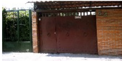
Portón y fachada de ladrillo
