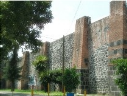
Fachada alta de piedra y ladrillo combinada con vegetación de las Trojes de Coapa, ex Hacienda.
